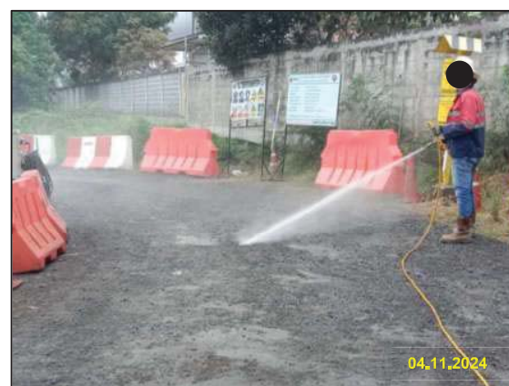
รูปที่ 2-3 การฉีดพรมน้ำเพื่อลดการฟุ้งกระจายของฝุ่นละออง บริเวณทางเข้าออกพื้นที่ก่อสร้าง
