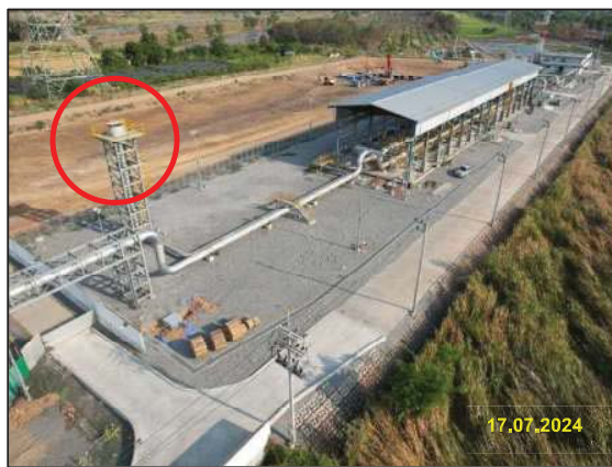
รูปที่ 2-28 ติดตั้งอุปกรณ์ควบคุมเสียง (Silencer) ที่ปล่องระบายก๊าซฯ (Vent Stack)
