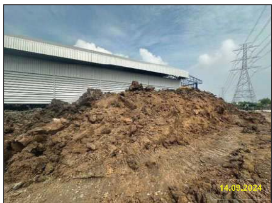
การจัดวางกองดินให้ห่างจากแหล่งน้ำ
