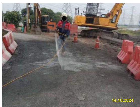
รูปที่ 2-3 การฉีดพรมน้ำเพื่อลดการฟุ้งกระจายของฝุ่นละออง บริเวณทางเข้าออกพื้นที่ก่อสร้าง
