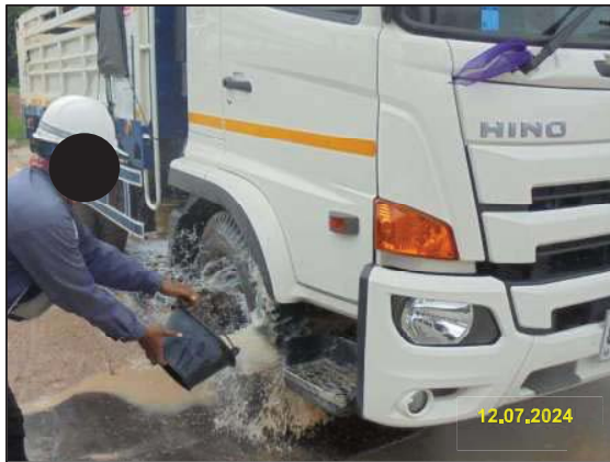
รูปที่ 2-7 การจัดทำพื้นที่ล้างล้อพร้อมทั้งล้างทำความสะอาดเศษดิน และเศษโคลนที่ติดกับล้อรถ ก่อนออกจากพื้นที่เก็บกองท่อ (Stock Yard) และพื้นที่ก่อสร้าง
