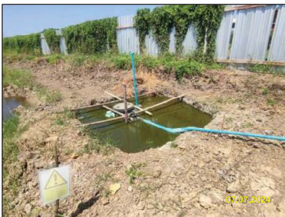
รูปที่ 2-11 การติดตั้งระบบบำบัดน้ำเสียสำเร็จรูปที่ได้มาตรฐาน / บ่อพักน้ำทิ้งโครงการบริเวณสำนักงาน ของโครงการ
