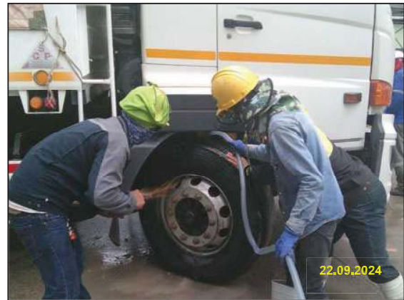
รูปที่ 2-7 การจัดทำพื้นที่ล้างล้อพร้อมทั้งล้างทำความสะอาดเศษดิน และเศษโคลนที่ติดกับล้อรถ ก่อนออกจากพื้นที่เก็บกองท่อ (Stock Yard) และพื้นที่ก่อสร้าง
