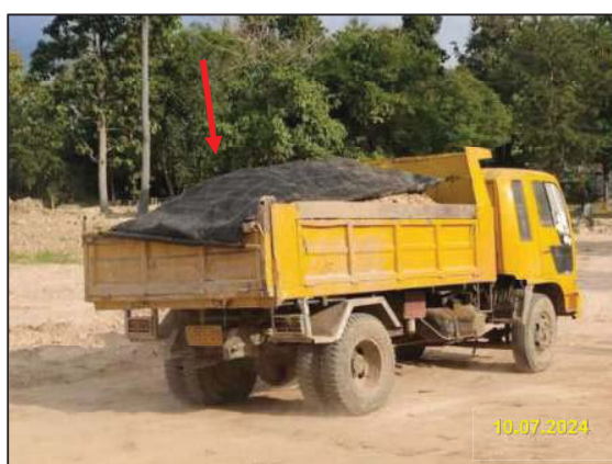
รูปที่ 2-4 การใช้ผ้าใบปิดคลุมรถบรรทุกระหว่างการขนย้ายวัสดุ
