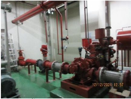
เครื่องสูบน้ำดับเพลิงชนิดเครื่องยนต์ดีเซล
