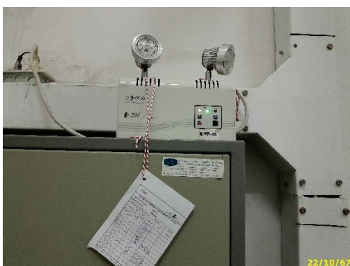
คอมไฟฟ้าแสงสว่างฉุกเฉิน
