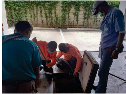
สูบล้างปลิวจากระบบบำบัดน้ำเสีย ภาพที่ 2.2-5 (ต่อ) ระบบบำบัดน้ำเสีย
