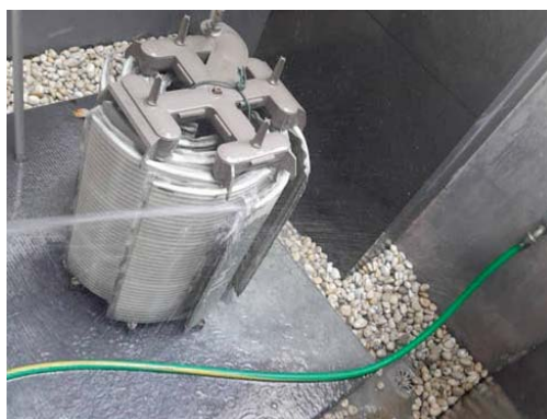
ล้างทำความสะอาดแผ่นกรองเครื่องปรับอากาศ
