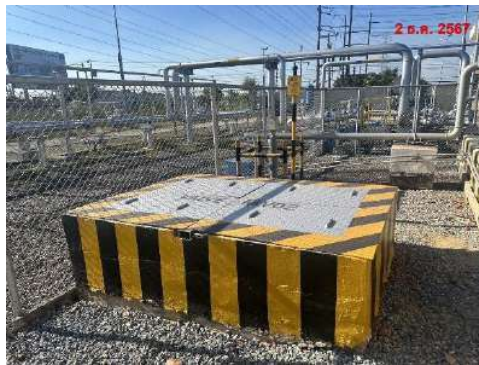
ภาพที่ 2.2-5 วาล์วควบคุม และระบบวาล์วใต้ดิน
