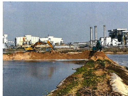
ภาพที่ 2-52 การตรวจสอบและซ่อมบำรุงคันบ่อบำบัดน้ำเสีย
