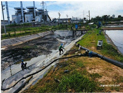
ภาพที่ 2-62 การขุดลอกตะกอนบ่อ EQ
