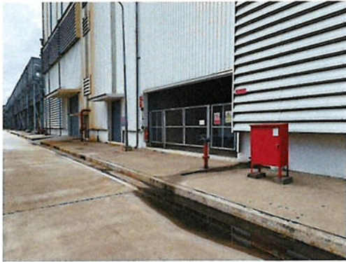
ภาพที่ 2-34 (ต่อ) ระบบดับเพลิงของโครงการ
