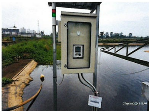
ภาพที่ 2-63 เครื่องตรวจวัดคุณภาพน้ำอัตโนมัติ
