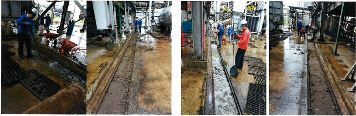
ภาพที่ 2-51 การขุดลอกรางระบายน้ำ
