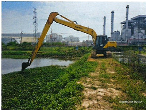
ภาพที่ 2-52 การตรวจสอบและซ่อมบำรุงคันบ่อบำบัดน้ำเสีย
