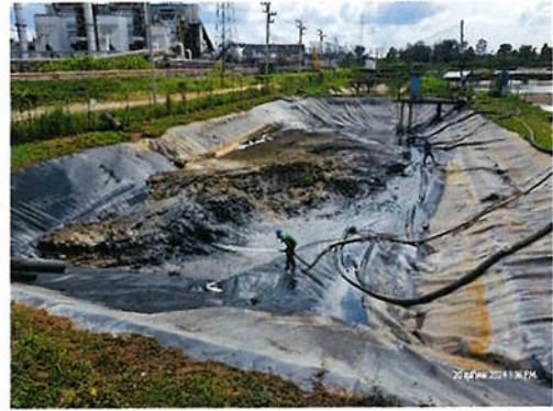
ภาพที่ 2-62 การขุดลอกตะกอนบ่อ EQ
