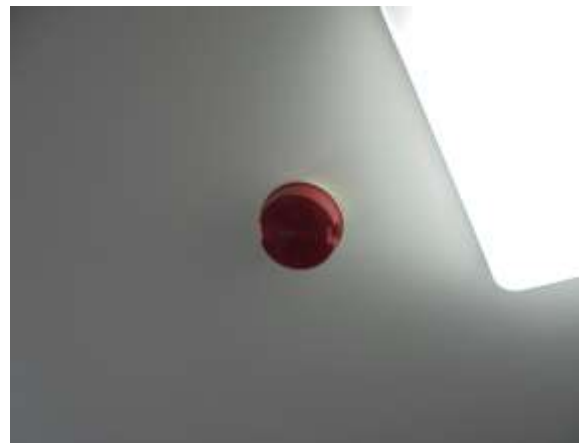
รูปที่ 28 อุปกรณ์ตรวจจับความร้อน
