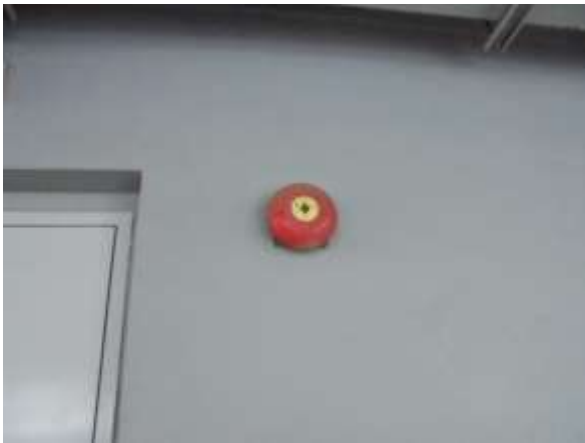
รูปที่ 27 อุปกรณ์เตือนภัยด้วยเสียง
