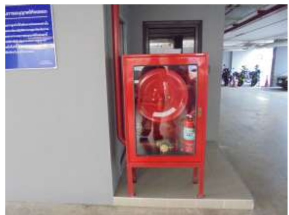
รูปที่ 30 ตู้เก็บสายฉีดน้ำดับเพลิงพร้อมอุปกรณ์
