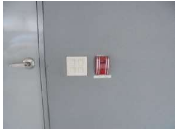
รูปที่ 26 อุปกรณ์เตือนภัยด้วยมือกด
