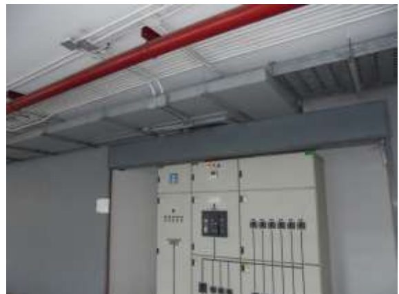
รูปที่ 18 การเดินสายไฟรวมถึงสายสัญญาณต่าง ๆ
