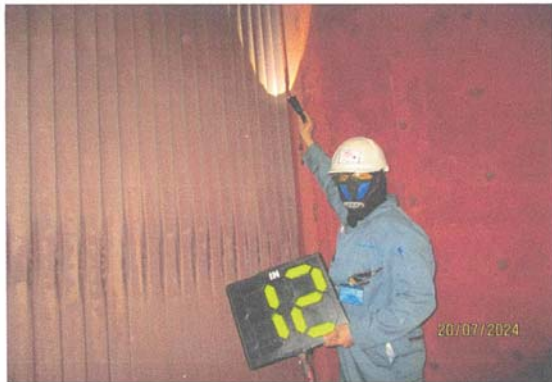
ตรวจสอบท่อน้ำต่างๆเพื่อตรวจสอบการรั่วหลังอัดน้ำที่ความดันที่กำหนด ด้าน HP Part หม้อไอน้ำหมายเลข 2( HRS-12 ) บริษัท ราชบุรีเวิลด์ โคเจนเนอเรชั่น จำกัด วันที่ 20 กรกฎาคม 2567
