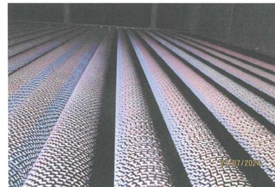
ตรวจสอบสภาพท่อน้ำไปด้าน HP Part ภายในหม้อน้ำ หม้อไอน้ำหมายเลข 2( HRS-12 ) บริษัท ราชบุรีเวิลด์ โคเจนเนอเรชั่น จำกัด วันที่ 20 กรกฎาคม 2567
