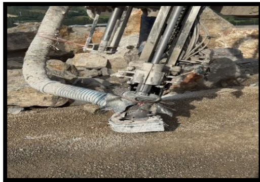
รูปที่ 2-42 รถเจาะมีที่ตัดฝุ่น
