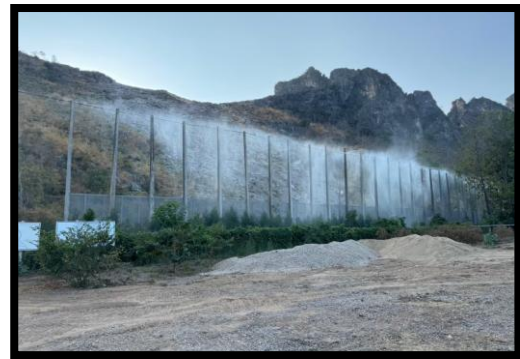
รูปที่ 2-11 ระบบสเปรย์น้ำ
