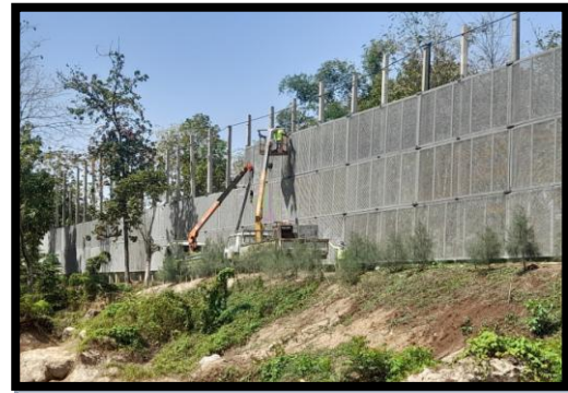
รูปที่ 2-39 ตะแกรงเหล็กกันหินกระเด็น
