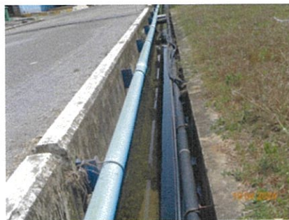
รูปที่ 4 รางระบายน้ำฝนภายในโรงงาน
