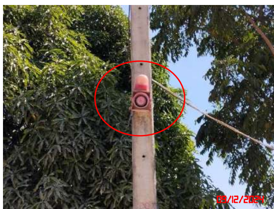
รูปที่ 10 เครื่องส่งสัญญาณเตือนการระเบิด
