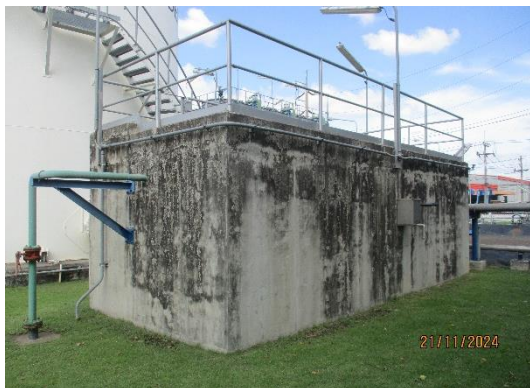
ภาพที่ 2-8 บ่อแยกน้ำ/น้ำมัน (Oil Separator)
