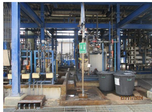
ภาพที่ 2-47 ฝักบัวชำระล้างร่างกายและที่ล้างตา (Safety Shower&Eye Washer)
