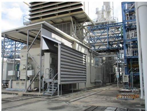
ภาพที่ 2-5 อาคารคลุมเครื่องจักร (Enclosure)
