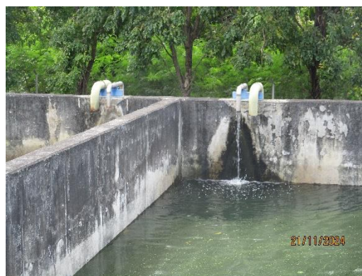
ระบบกระจายน้ำบริเวณบ่อพักน้ำหล่อเย็น
