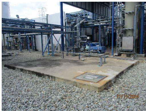
ภาพที่ 2-11 บ่อปรับสภาพความเป็นกรด-ด่าง (Neutralization Pit)
