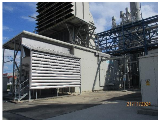
ภาพที่ 2-5 อาคารคลุมเครื่องจักร (Enclosure)
