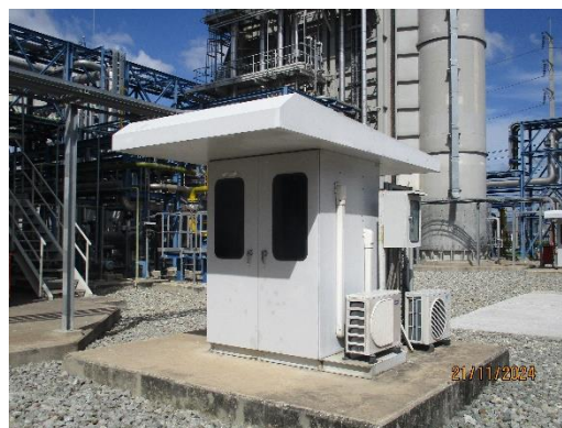
ภาพที่ 2-2 ระบบตรวจสอบคุณภาพอากาศจากปล่องระบายอากาศแบบต่อเนื่อง (CEMs)
