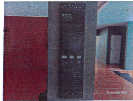
ภาพที่ 2-12 เครื่องมือตรวจวัดน้ำสระว่ายน้ำ (pH,Cl)
