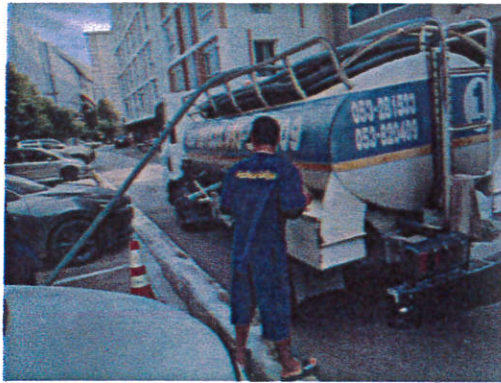
ภาพที่ 2-9 สูบตะกอนและตกไขมัน
