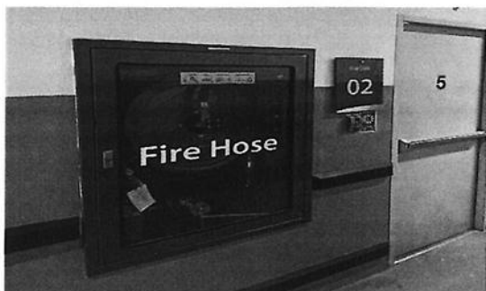
ผ 3- 35 ติดตั้งตู้ FCH พร้อมอุปกรณ์ภายในตู้ มีถังดับเพลิงแบบ Dry Chemical Extinguisher
