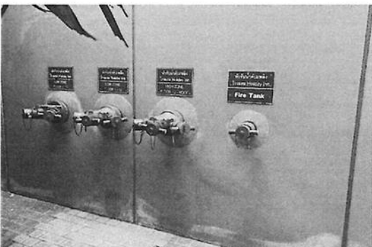
ผ 3- 34 ติดตั้งหัวรับน้ำดับเพลิงภายนอกชนิดข้อต่อสวมเร็วและถังเก็บน้ำรองเพื่อการดับเพลิง
