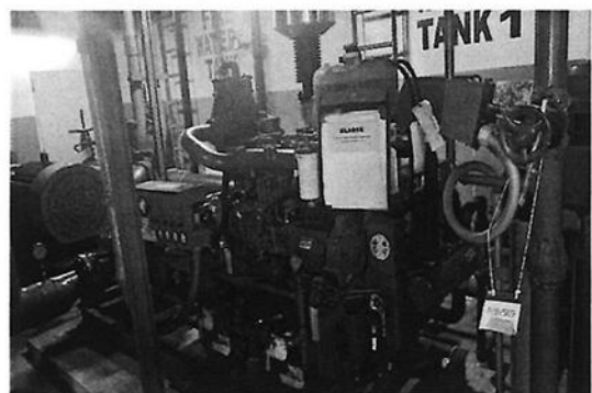
ผ 3- 23 เครื่องดีเซล สำหรับสูบน้ำดับเพลิง
