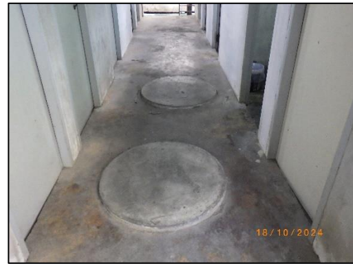
รูปที่ 2-2 ห้องสุขาและจุดติดตั้งบ่อเกรอะ บริเวณหลังโกดังพักสินค้า
