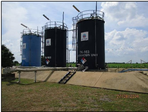
ภาพถ่ายที่ 2.2-7 คั่นคอนกรีตล้อมรอบถังกักเก็บ
