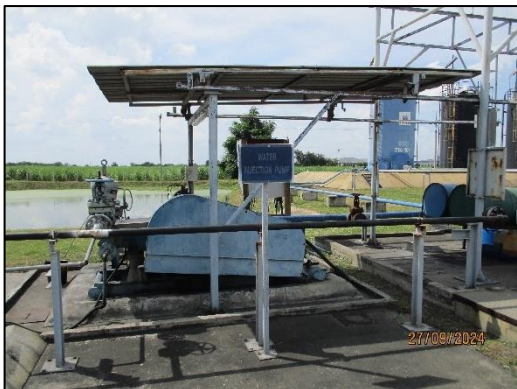
ภาพถ่ายที่ 2.2-9 อุปกรณ์อัดกลับน้ำไปยังฐานหลุมผลิต
