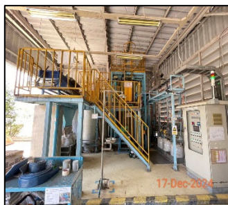
ภาพที่ 2.14 ระบบบำบัดน้ำเสียแบบตกตะกอนทางเคมี
