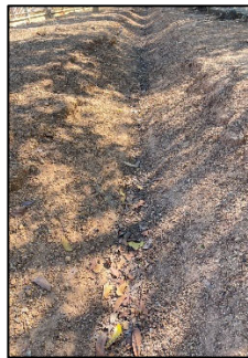
ภาพที่ 2.19 รางดินระบายน้ำของโครงการ
