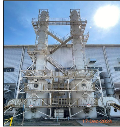
ภาพที่ 2.2 ระบบบำบัดมลพิษทางอากาศ (ระบบดักฝุ่นเปียก Wet Scrubber)
