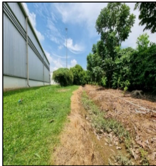
ภาพที่ 2.19 รางดินระบายน้ำของโครงการ
