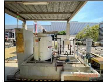
ภาพที่ 2.13 ระบบบำบัดน้ำเสียในส่วนของการเติมอากาศ
