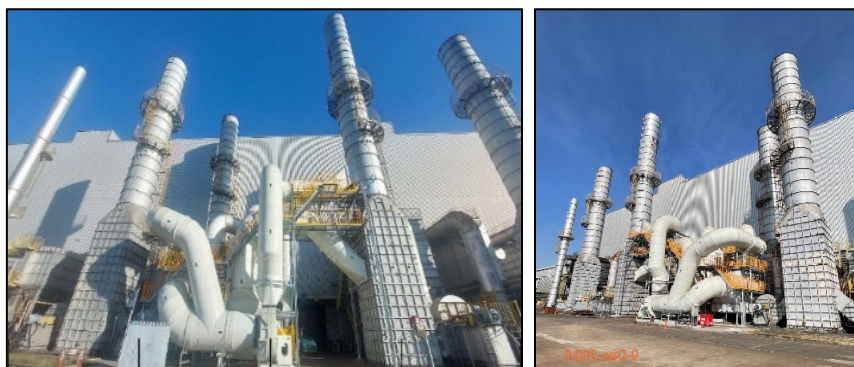
ภาพที่ 2.60 ระบบบำบัดมลพิษทางกลิ่นและระบบบำบัดมลพิษทางอากาศ แบบ Wet Scrubber และ Activated Carbon
