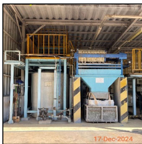
ภาพที่ 2.14 ระบบบำบัดน้ำเสียแบบตกตะกอนทางเคมี
