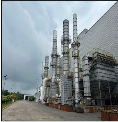
ภาพที่ 2.1 ระบบบำบัดมลพิษทางอากาศ (ระบบดักฝุ่นแบบถุงกรอง Bag Filter)
