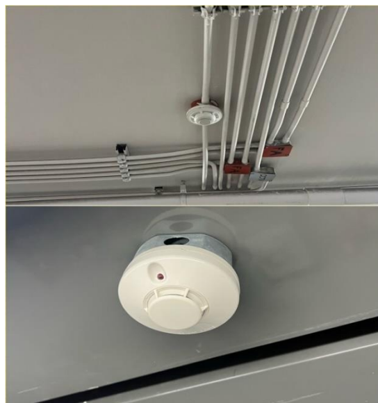
รูปที่ 2.4.8-2 อุปกรณ์ตรวจจับควันและความร้อน
