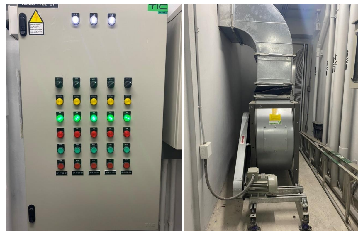
ภาคผนวกที่ 3-38 ระบบป้องกันอัคคีภัย และระบบระบายอากาศ ภายในระบบจอตรยหนต์อัตโนมัติ
