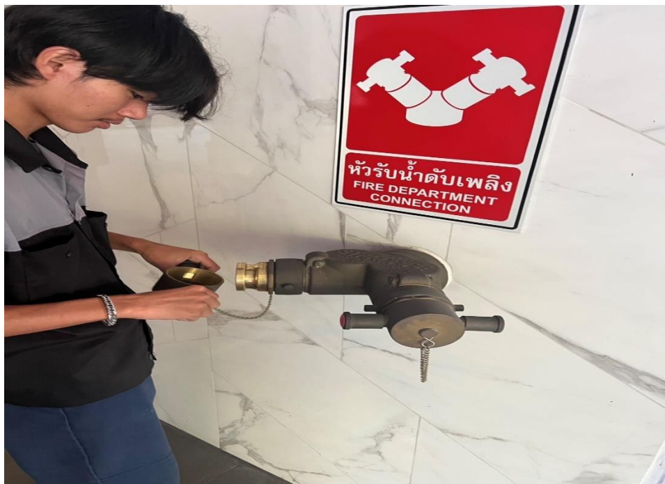
ภาคผนวกที่ 3-26 ตรวจสอบห้รรับน้ำดับเพลิง
