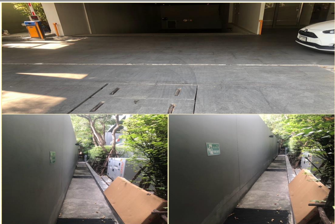
ภาคผนวกที่ 3-4 ป่อพัก ท่อระบายน้ำรอบโครงการและปอดักขยะบริเวณจุดเชื่อมต่อ
