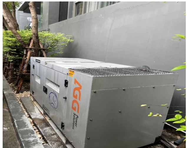
รูปที่ 2.4.6-2 เครื่องกำเนิดไฟฟ้าสำรอง
