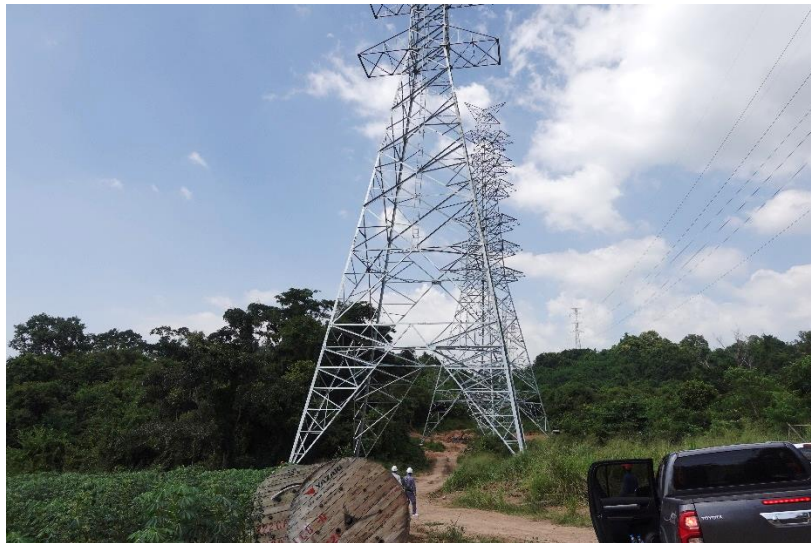
รูปที่ 1.15 การก่อสร้างเสาโครงเหล็กแล้วเสร็จในช่วงที่ 1 ของโครงการระบบโครงข่ายไฟฟ้า 230 กิโลโวลต์ จุดเชื่อมบางละมุง2 – บางละมุง2 ในพื้นที่ป่าสงวนแห่งชาติป่าบางละมุง
