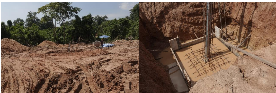
รูปที่ 1.16 การก่อสร้างฐานรากเสาในช่วงที่ 1 ของโครงการระบบโครงข่ายไฟฟ้า 230 กิโลโวลต์ จุดเชื่อมบางละมุง2 – บางละมุง2
