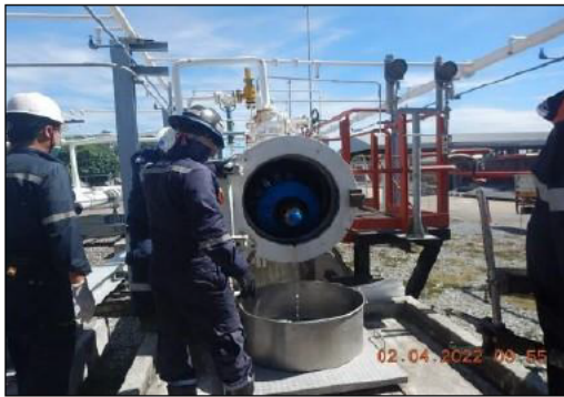
รูปที่ 2-3 การส่ง Intelligent Pig เพื่อตรวจสอบท่อน้ำมัน
