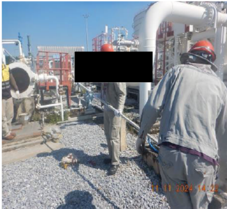
รูปที่ 2-2 การทำความสะอาดท่อน้ำมันด้วย Cleaning Pig
