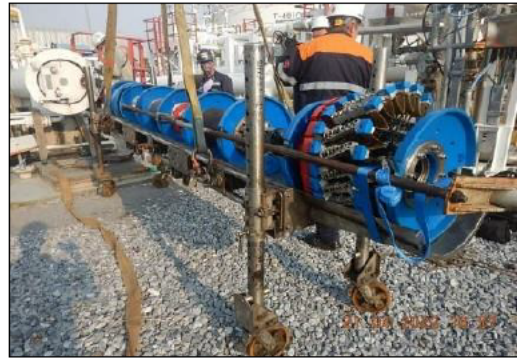
รูปที่ 2-3 การส่ง Intelligent Pig เพื่อตรวจสอบท่อน้ำมัน
