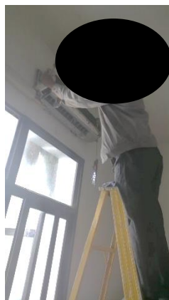
ภาพถ่ายที่ 2.2-17 การทำความสะอาดเครื่องปรับอากาศ
