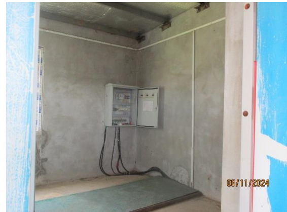
ภาพถ่ายที่ 2.2-5 ระบบควบคุมระบบบำบัดน้ำเสีย
