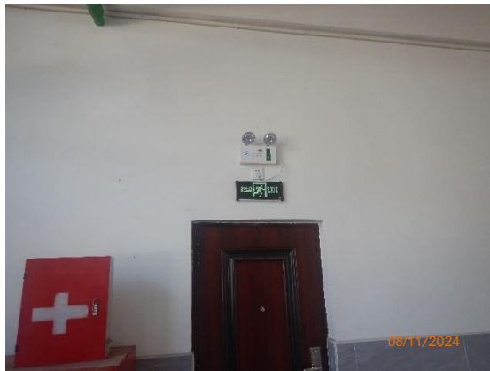
ภาพถ่ายที่ 2.2-16 ไฟส่องสว่างฉุกเฉิน
