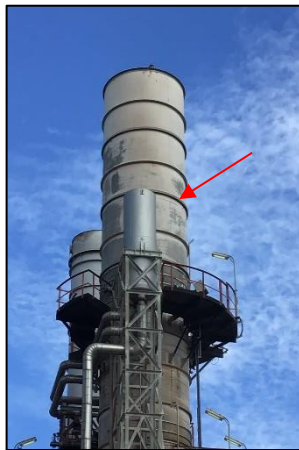
รูปที่ 2-6 อุปกรณ์ลดเสียง (Silencer) ที่ GTG-3
