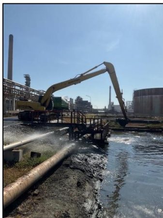
รูปที่ 2-21 การขุดลอกตะกอนในบ่อบำบัดปี พ.ศ. 2567
