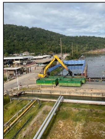
รูปที่ 2-21 การขุดลอกตะกอนในบ่อบำบัดปี พ.ศ. 2567
