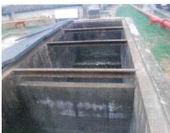
ตรวจพบกานเหล็กมีรอยผุกร่อน
