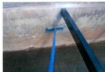
ทำความสะอาดคั่นกรองคอนกรีตด้านใน
