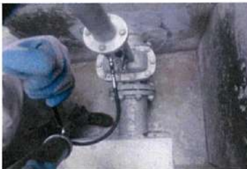
อัดจาระบีใส่ บริเวณก้านวาล์ว เปิด-ปิดวาล์ว
