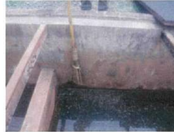
ทำความสะอาดผนังคอนกรีตด้านใน
