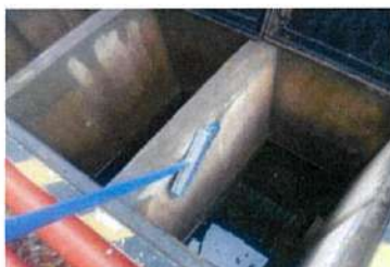
ทำความสะอาดผืนลอยคอนกรีตด้านใน
