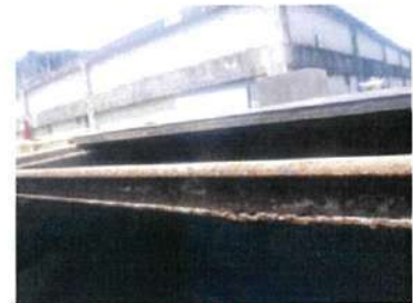
ตรวจพบกานเหล็กมีรอยผุกร่อน
