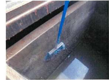
ทำความสะอาดผนังคอนกรีตด้านใน
