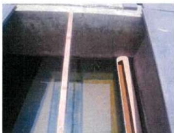
ทำการตรวจสอบและทำความสะอาด interceptor
