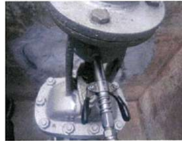
อัดจาระบีใส่บริเวณก้านวาล์ว เปิด-ปิดวาล์ว
