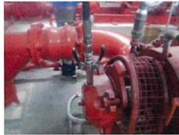
ตรวจสอบการหล่อลื่นและเช็คจาระบีลูกปืน ( Bearing )
