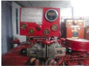
ทดสอบสวิตช์เครื่องชนิดแบบ manual และแบบ Auto
