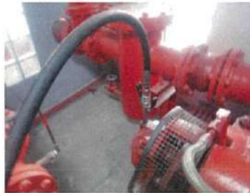
ตรวจสอบการหล่อลื่นและอัดจาระบีลูกปืน ( Bearing )
