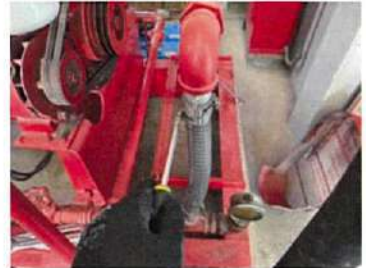
ตรวจสอบท่อและจุดเชื่อมต่อของน้ำหล่อเย็น
