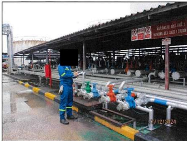
ภาพถ่ายที่ 2.2-8 การตรวจสอบบริเวณท่อส่งน้ำมันด้วยสายตา
