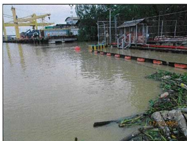
ภาพถ่ายที่ 2.2-11 ทุ่นกักเก็บคราบน้ำมันบริเวณท่าเทียบเรือ
