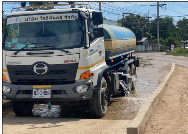
รูปที่ 2-4 การล้างล้อรถ
