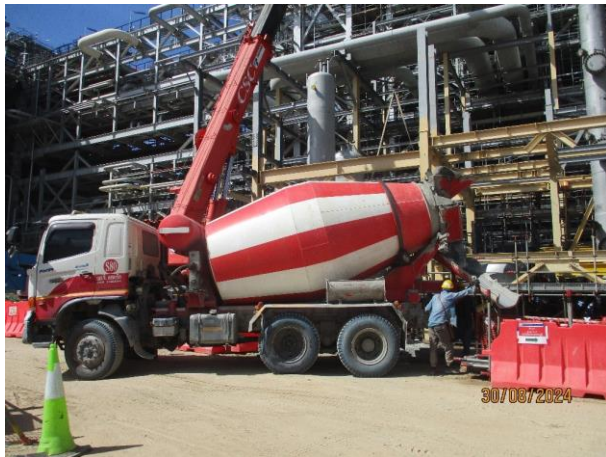
รูปที่ 2-10 การทำความสะอาดรางระบายคอนกรีตของรถชนคอนกรีต
