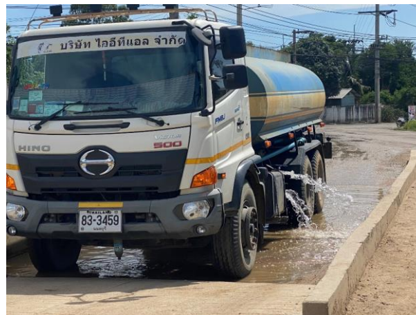
รูปที่ 2-6 ที่ล้างล้อรถบรรทุก
