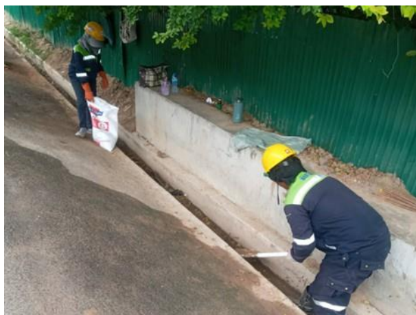
รูปที่ 2-10 การทำความสะอาดรางระบายคอนกรีตของรถชนคอนกรีต
