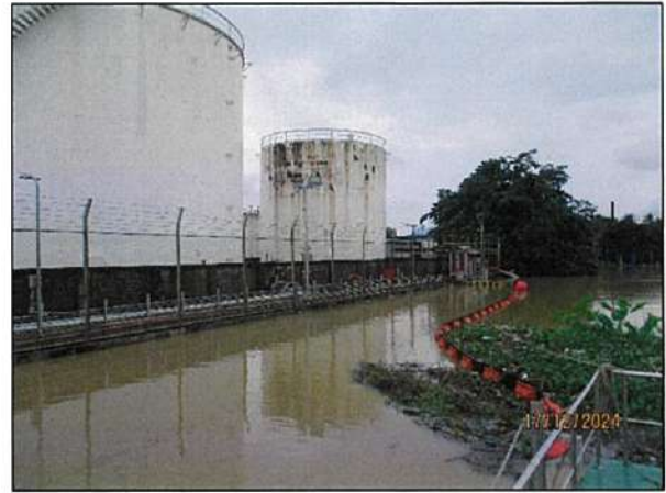
ภาพถ่ายที่ 2.2-17 พุน้ำกักเก็บคราบน้ำมันบริเวณท่าเทียบเรือ
