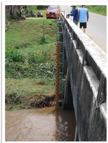
รูปที่ 5.2.1-5 (ต่อ) ลงพื้นที่ติดตั้งสถานีสำรวจอุทกวิทยา น้ำแม่ตาช้าง บ้านใหม่เจริญ ตำบลป่าแดด อำเภอแม่สรวย จังหวัดเชียงราย (ท้ายโครงการอ่างเก็บน้ำแม่ตาช้าง จังหวัดเชียงราย)
