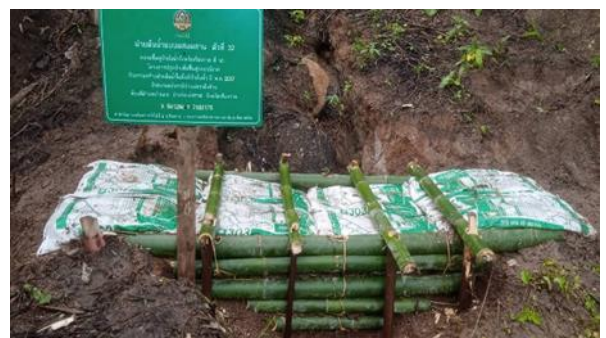
รูปที่ 5.1.3-5 (ต่อ) กิจกรรมก่อสร้างฝายชะลอน้ำแบบผสมผสานจำนวน 83 แห่ง
