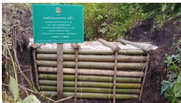
รูปที่ 5.1.3-5 (ต่อ) กิจกรรมก่อสร้างฝายชะลอน้ำแบบผสมผสานจำนวน 83 แห่ง
