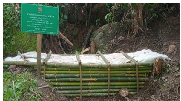
รูปที่ 5.1.3-4 (ต่อ) กิจกรรมก่อสร้างฝายชะลอน้ำแบบผสมผสานจำนวน 84 แห่ง
