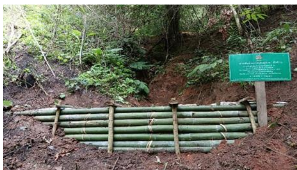
รูปที่ 5.1.3-4 (ต่อ) กิจกรรมก่อสร้างฝายชะลอน้ำแบบผสมผสานจำนวน 84 แห่ง
