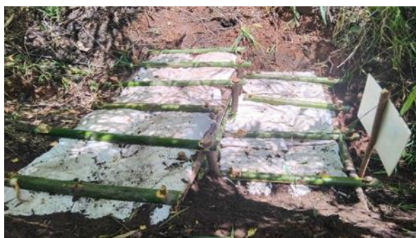
รูปที่ 5.1.3-4 กิจกรรมก่อสร้างฝายชะลอน้ำแบบผสมผสานจำนวน 84 แห่ง
