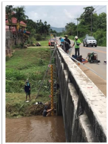
รูปที่ 5.2.1-5 (ต่อ) ลงพื้นที่ติดตั้งสถานีสำรวจอุทกวิทยา น้ำแม่ตาช้าง บ้านใหม่เจริญ ตำบลป่าแดด อำเภอแม่สรวย จังหวัดเชียงราย (ท้ายโครงการอ่างเก็บน้ำแม่ตาช้าง จังหวัดเชียงราย)
