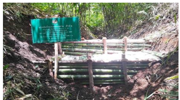
รูปที่ 5.1.3-4 กิจกรรมก่อสร้างฝายชะลอน้ำแบบผสมผสานจำนวน 84 แห่ง
