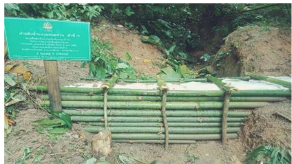
รูปที่ 5.1.3-5 กิจกรรมก่อสร้างฝายชะลอน้ำแบบผสมผสานจำนวน 83 แห่ง
