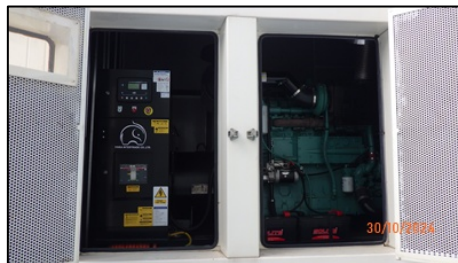
รูปที่ 2.69 เครื่องไฟฟ้าสำรอง
