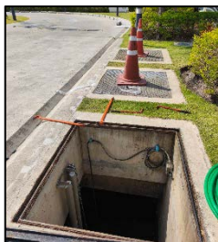
รูปที่ 2.17 เครื่องสูบน้ำ ขนาด 0.03 ลบ.ม./วินาที (สำรอง) ภายในบ่อหนองน้ำ
