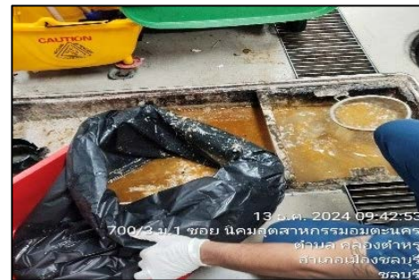
รูปที่ 2.11 พนักงานตักน้ำมันและไขมัน
