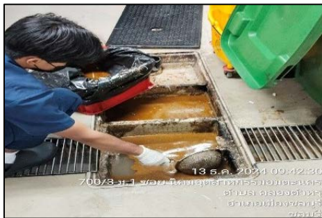
รูปที่ 2.11 พนักงานตักน้ำมันและไขมัน
