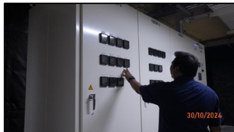
รูปที่ 2.12 ติดตั้งมิเตอร์ไฟฟ้าสำหรับระบบบำบัดน้ำเสีย
