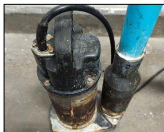
รูปที่ 2.17 เครื่องสูบน้ำ ขนาด 0.03 ลบ.ม./วินาที (สำรอง) ภายในบ่อหนองน้ำ
