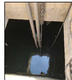
รูปที่ 2.17 เครื่องสูบน้ำ ขนาด 0.03 ลบ.ม./วินาที (สำรอง) ภายในบ่อหนองน้ำ
