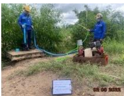
สูบน้ำออกจากบ่อ
