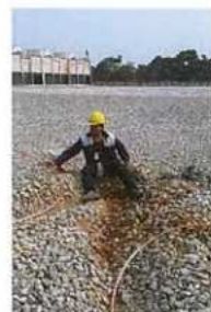
Block 1 อาคารเก็บก๊าซ N 2 &Co 2 ขณะทำการติดตั้ง ตอกแท่งกรวดทองแดง สายล่อฟ้า
