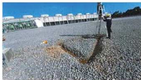
Block 1 อาคารเก็บก๊าซ N 2 &Co 2 ขณะทำการติดตั้ง ชุดฝังแท่งกรวดทองแดง สายล่อฟ้า
