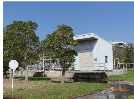
รูปที่ 2.2-12 ระบบบำบัดน้ำเสียแบบเติมอากาศในการบำบัดน้ำเสียจากอาคารสำนักงาน
