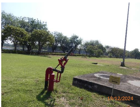
รูปที่ 2.2-38 การติดตั้ง Monitoring Nozzle รอบ Tank Farm
