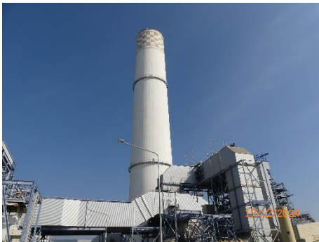
รูปที่ 2.2-4 ระบบกำจัดก๊าซ SO_2 (Flue Gas Desulfurization: FGD)
