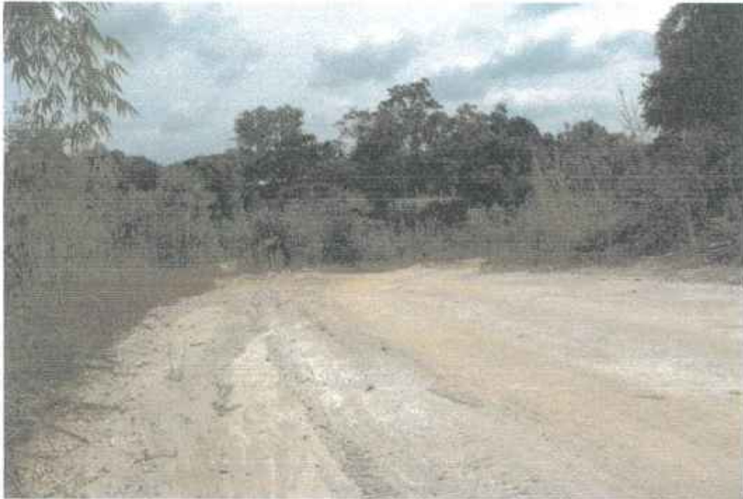
รูปที่ 1 สภาพพื้นผิวที่หลังแนวยอดของความลาดชันของบ่อเหมือง/ชั้นบันได ไม่เกิดการทรุดตัว
