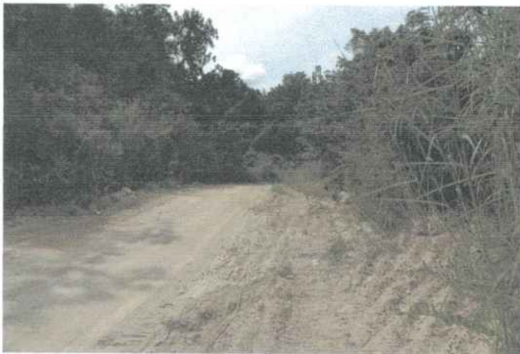
รูปที่ 17 เส้นทางลำเลียงบริเวณปากบ่อ ไม่มีพุ่มบ่อ จนเป็นอันตรายหรืออุปสรรคกับการขนส่ง
