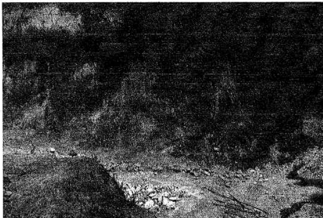
รูปที่ 10 สภาพดินผาบริเวณบ่อเหมืองด้านทิศตะวันออก ไม่มีน้ำซึม หรือเกิดแอ่งสะสมตัวของน้ำ บริเวณด้านหน้าดินของแนวความลาดชันรวมของบ่อเหมือง/ชั้นบันได
