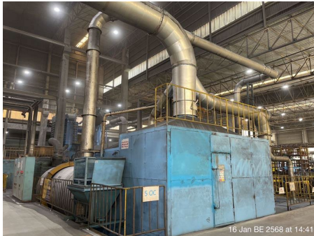
ภาพที่ 2-7 ระบบดูดอากาศ (ระบบปิด) ในบริเวณที่มี กระบวนการทำงานแบบทราาย
