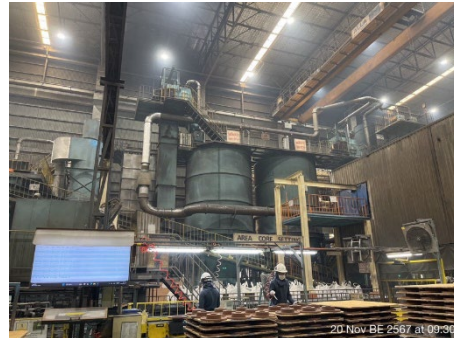
ภาพที่ 2-8 ระบบดูดอากาศเฉพาะจุด
