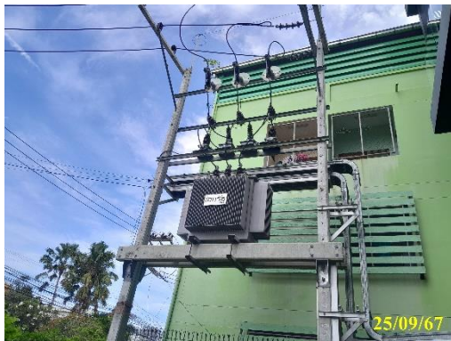
หม้อแปลงไฟฟ้า ขนาด 1,000 KVA
