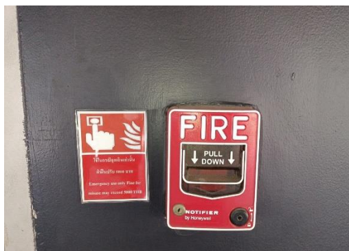
ภาพที่ 35 เครื่องแจ้งเหตุโดยใช่มือดึง (Manual Station)
