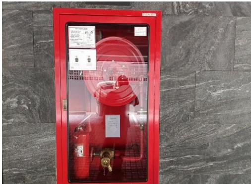
ภาพที่ 31 ตู้เก็บสายฉีดน้ำดับเพลิงพร้อมอุปกรณ์ (FHC)
