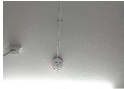
ภาพที่ 34 เครื่องตรวจจับความร้อน (Heat Detector)
