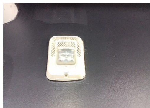
ภาพที่ 36 ลำโพงแจ้งเหตุเพลิงไหม้ (Voice Tone Alarm Loudspeaker)
