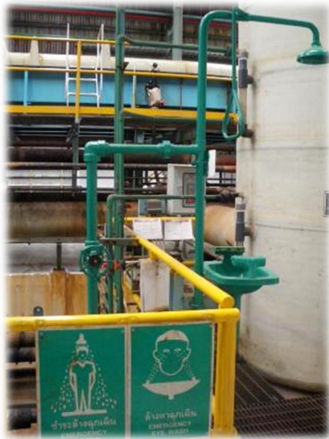
อ่างล้างตาและฝักบัวฉุกเฉิน
