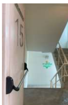
ภาพ 2-29 โครงการ มีประตูกั้นไฟกั้นระหว่างทางเดินภายในอาคารกับบันไดหนีไฟในแต่ละชั้น
