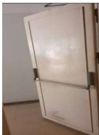
ภาพ 2-29 โครงการ มีประตูกั้นไฟกั้นระหว่างทางเดินภายในอาคารกับบันไดหนีไฟในแต่ละชั้น
