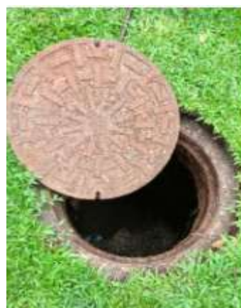
ภาพ 2-8 บ่อดักไขมัน (ขอบปากบ่อแห้งและไม่มีตะกอน)
