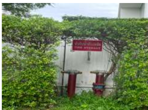
ภาพ 2-22 หัวรับน้ำดับเพลิงภายนอกอาคาร ติดตั้งบริเวณทิศตะวันออกใกล้กับทางเข้า-ออกโครงการ
