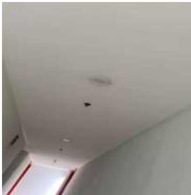
ภาพ 2-27 เครื่องตรวจจับความร้อน ( Heat Detector) และเครื่องตรวจจับควัน (Smoke Detector)
