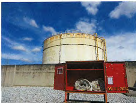
ภาพที่ 2-45 สายฉีดและหัวฉีดน้ำดับเพลิง
