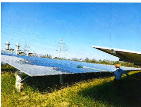
ภาพที่ 2-58 การทำความสะอาดเซลล์แสงอาทิตย์
