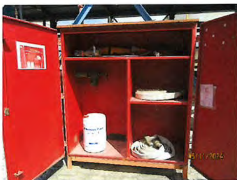
ภาพที่ 2-47 Water Foam Hose Station
