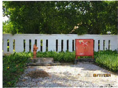
ภาพที่ 2-45 สายฉีดและหัวฉีดน้ำดับเพลิง
