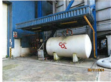
ภาพที่ 2-44 CO 2 Extinguishing System
