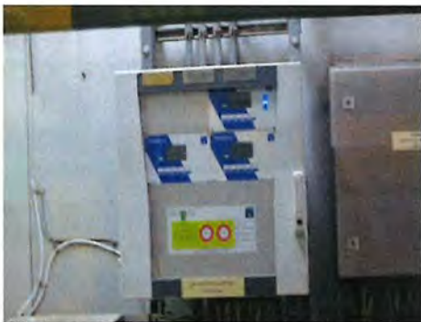
ภาพที่ 2-36 อุปกรณ์ตรวจสอบการรั่วไหลของก๊าซ (Gas Detector)
