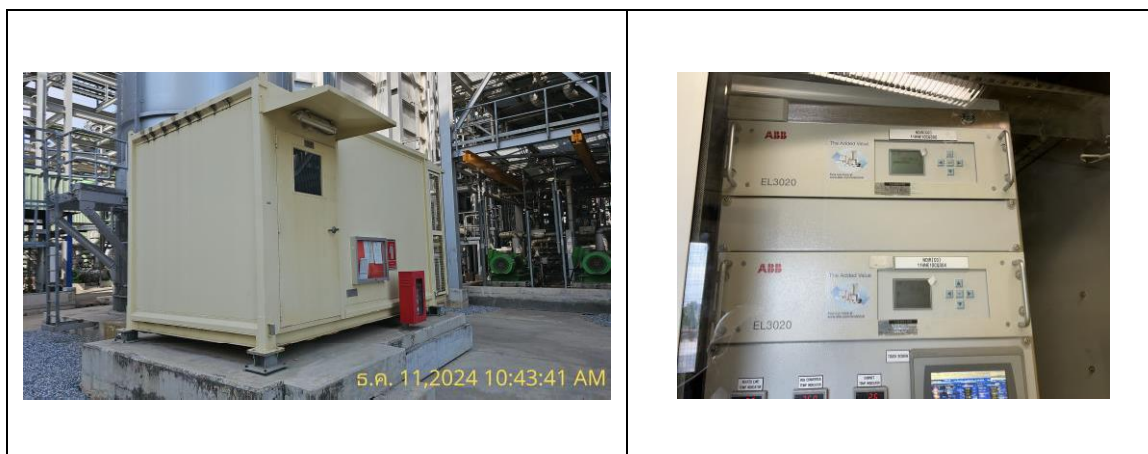
รูปที่ 3.2-1 : ระบบการตรวจวัดคุณภาพอากาศจากปล่องอย่างต่อเนื่อง (CEMS) ของโครงการ
