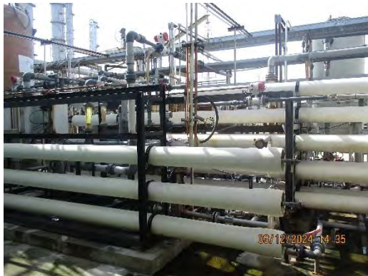
ภาพที่ 2.1-54 ระบบ RO unit
