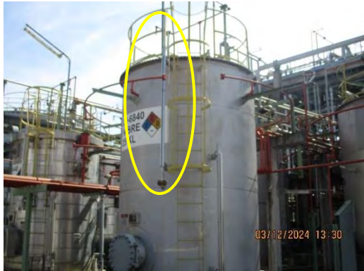
ภาพที่ 2.1-34 ระบบตรวจสอบระดับสารในถังเก็บกัก
