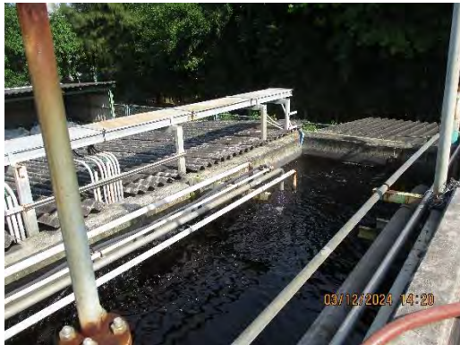
บ่อ Equalization โรงงาน 1
