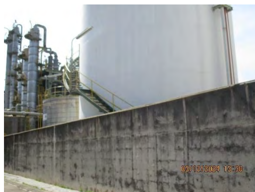
ภาพที่ 2.1-33 กำแพงกันถังเก็บกักสารเคมี
