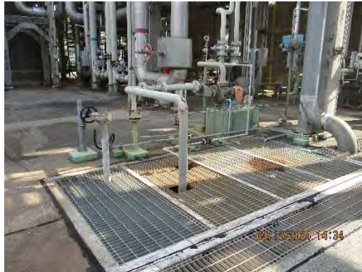
ภาพที่ 2.1-9 ระบบแยกน้ำมัน (Water Pit)
