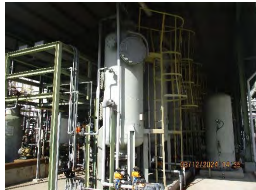
ภาพที่ 2.1-54 ระบบ RO unit
