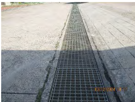
ภาพที่ 2.1-16 รางระบายน้ำรอบอาคารจัดเก็บกากของเสีย
