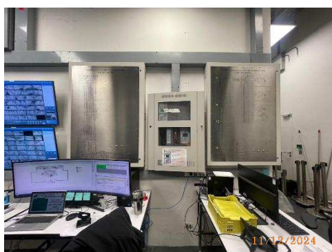
รูปที่ 40 ระบบควบคุมแจ้งเตือนเพลิงไหม้ (Fire Alarm Control Panel)
