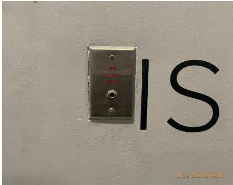
รูปที่ 49 โทรศัพท์แจ้งเหตุเพลิงไหม้ (Fire Man Telephone Outlet)
