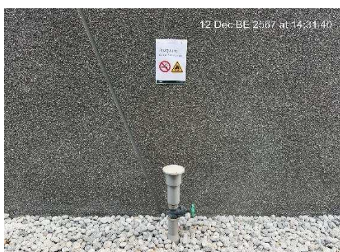
รูปที่ 20 การระบายก๊าซมีเทนของโครงการ
