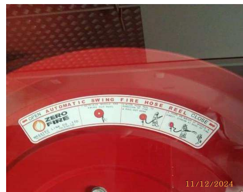
รูปที่ 51 ตู้เก็บสายฉีดน้ำดับเพลิง และป้ายแนะนำการใช้อุปกรณ์
