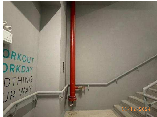
รูปที่ 50 ระบบท่อยืน (Fire Stand Pipe)
