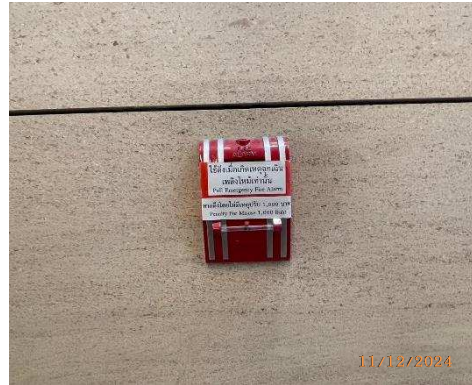
รูปที่ 45 เครื่องแจ้งเหตุโดยใช้มือดึง (Manual Pull Station)
