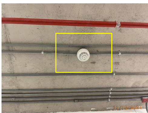
รูปที่ 42 เครื่องตรวจจับควัน (Smoke Detector)
