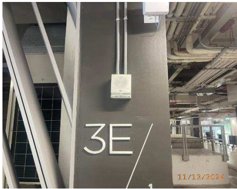
รูปที่ 44 ลำโพงแจ้งสัญญาณเตือนภัย (Fire Alarm Speaker)
