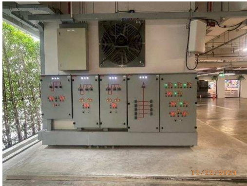
รูปที่ 22 ระบบมอเตอร์ไฟฟ้าสำหรับระบบบำบัดน้ำเสีย
