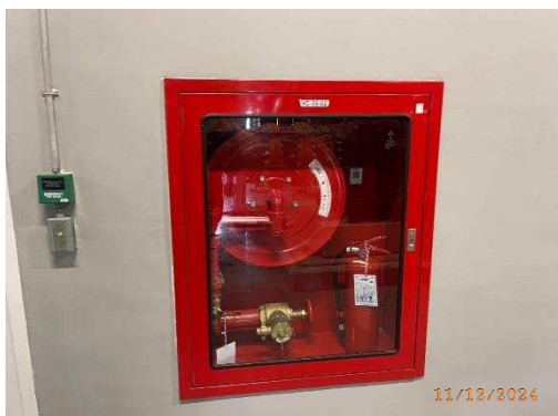
รูปที่ 51 ตู้เก็บสายฉีดน้ำดับเพลิง และป้ายแนะนำการใช้อุปกรณ์
