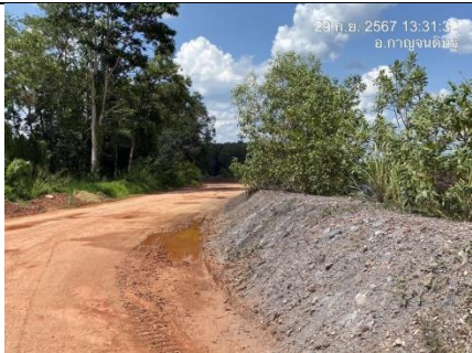
รูป Q สร้างคันทำนบความกว้างฐาน 5 เมตร สูง 3 เมตร และสันคันด้านบนกว้าง 2.5 เมตรพร้อมปลูกพืชคลุมดิน
