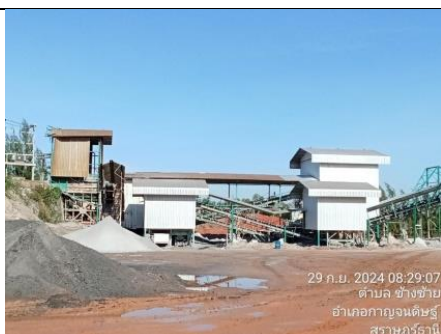
รูป W สร้างอาคารปิดคลุม Hopper, Primary Crusher และ ตระแกรงคัดขนาดแร่ พร้อมทั้งติดตั้งระบบสเปรย์น้ำ
