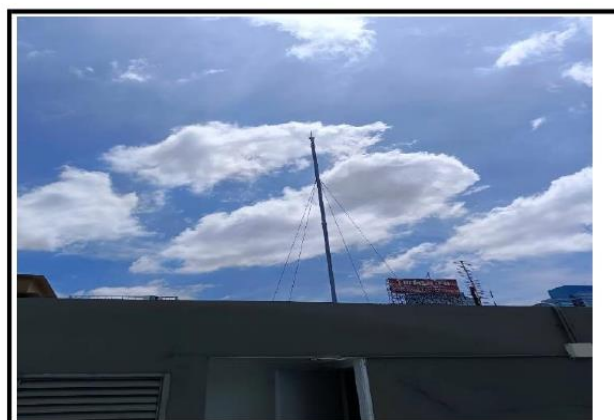
รูปที่ 2-48 ระบบป้องกันอันตรายฟ้าผ่า
