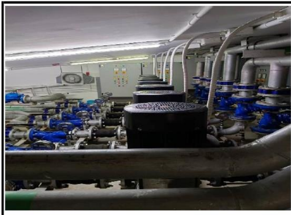
รูปที่ 3.18 Transfer pump
