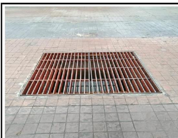
รูปที่ 2-15 ตะแกรงระบายน้ำดักเศษขยะ
