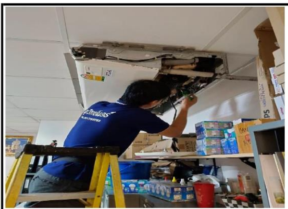
รูปที่ 3.23 ทำความสะอาดเครื่องปรับอากาศ
