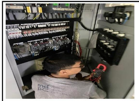
รูปที่ 3.34 ตรวจสอบเครื่องสูบน้ำ
