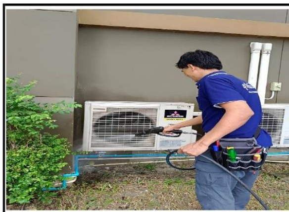
รูปที่ 2-58 ล้างทำความสะอาดคอนเดนสซิ่ง
