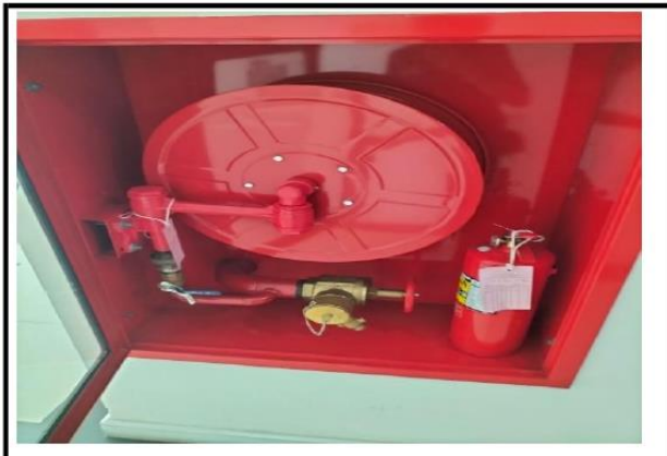
รูปที่ 2-43 ถังดับเพลิงเคมี
