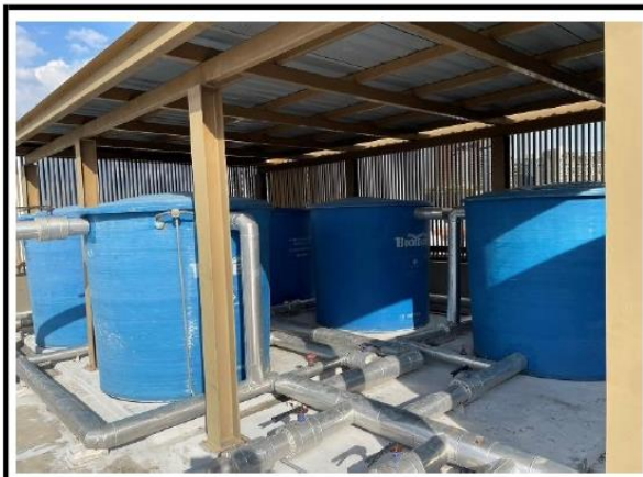
รูปที่ 3.16 ตรวจสอบถังสำรองน้ำใช้และแนวท่อ
