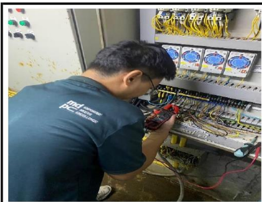
รูปที่ 3.29 ตรวจสอบระบบไฟสระว่ายน้ำ
