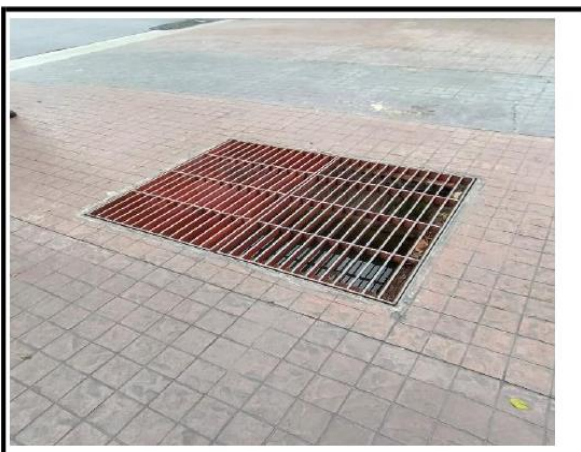
รูปที่ 2-23 ติดตั้งตะแกรงดักมูลฝอย
