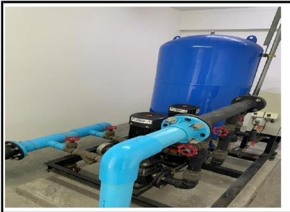
รูปที่ 3.19 Booster pump
