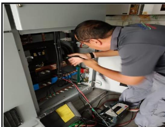
รูปที่ 2-16 ช่างอาคารตรวจสอบระบบไฟฟ้า MDB
