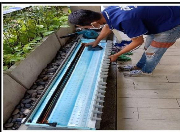
รูปที่ 2-57 ล้างทำความสะอาดแผ่นกรองเครื่องปรับอากาศ
