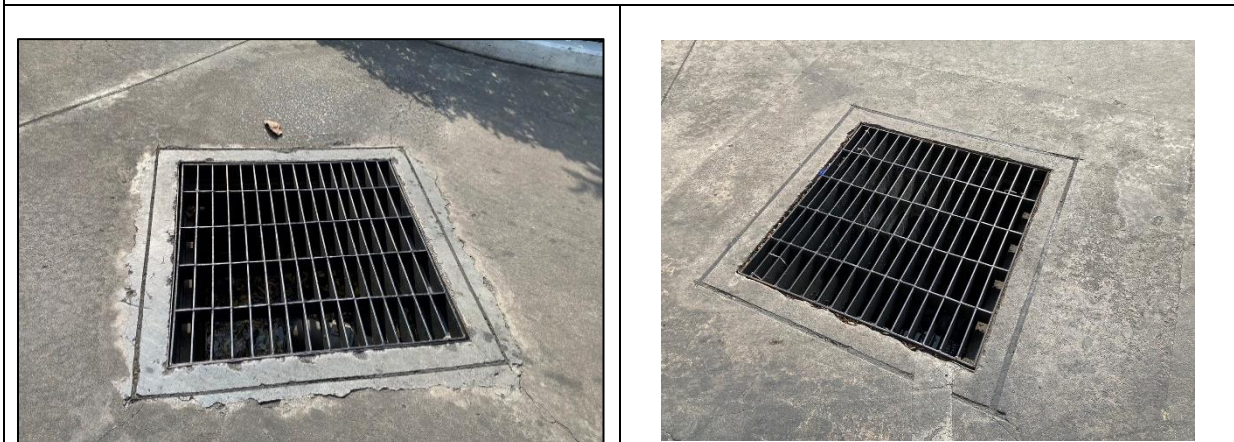
ภาพที่ 8 ตะแกรงดักขยะที่ Man hole สุดท้าย
