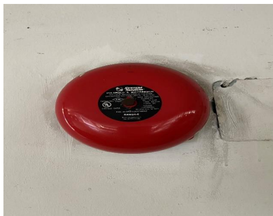
ภาพที่ 22 Bell ส่งสัญญาณเตือนอัคคีภัย
