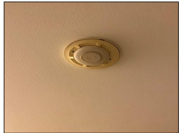
ภาพที่ 21 เครื่องตรวจจับความร้อน
