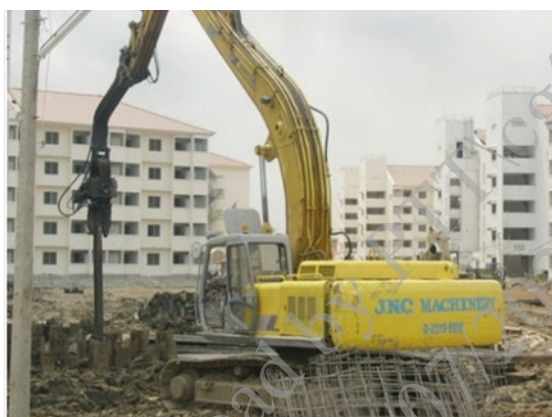
การปักแผ่นSheet Pile ด้วยรถแบคโฮติดหัวVirbro
