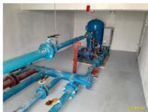
ปั้มน้ำเสริมแรงดันอาคาร C
