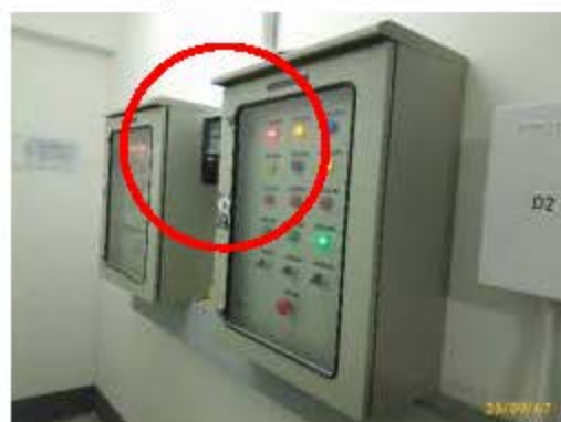
ระบบมิเตอร์ไฟฟ้าแยก
