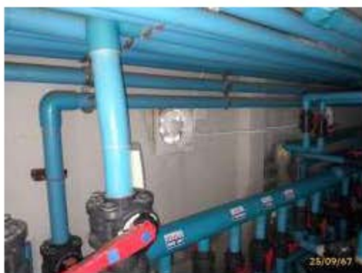
ระบบระบายอากาศแบบวิธีกล
