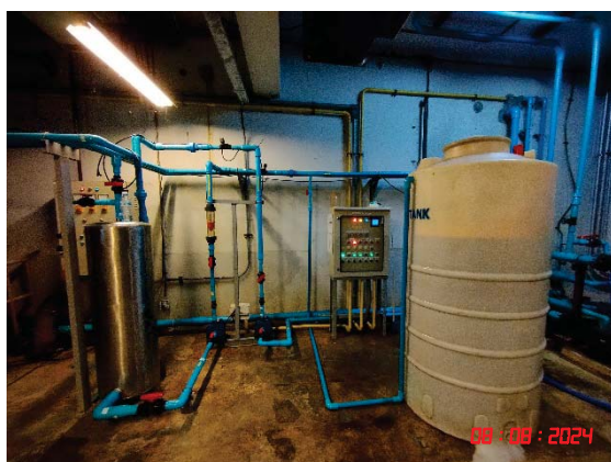
รูปที่ 8 ระบบบำบัดน้ำเสียเบื้องต้น
