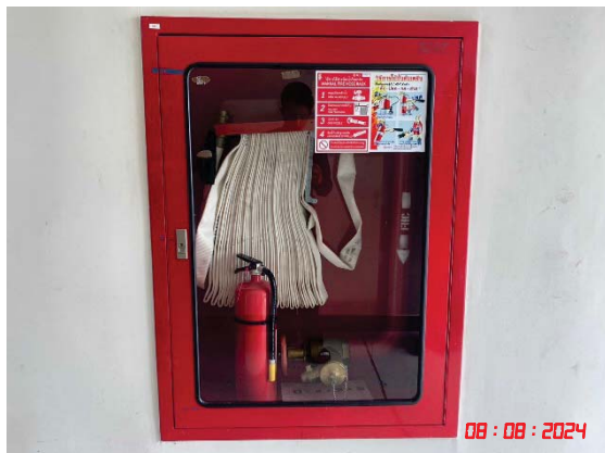
ตู้เก็บสายฉีดย้ำดับเพลิงพร้อมอุปกรณ์
