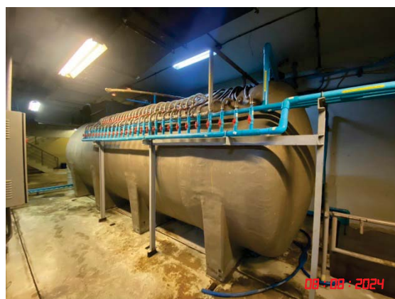
รูปที่ 8 ระบบบำบัดน้ำเสียเบื้องต้น
