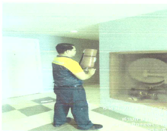
ตรวจเช็คถังดับเพลิง เดือน/ครั้ง
