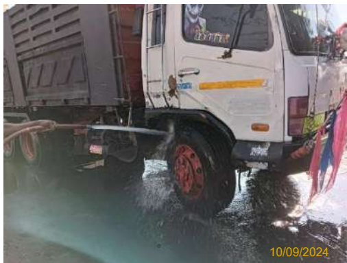
รูปที่ 2-22 พื้นที่ล้างล้อรถก่อนออกนอกโครงการ
