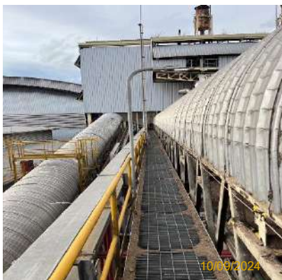
รูปที่ 2-19 การปิดครอบสายพานลำเลียงขานอ้อย
