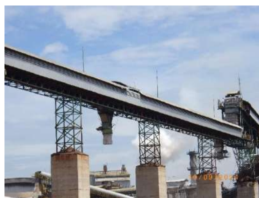
รูปที่ 2-19 การปิดครอบสายพานลำเลียงขานอ้อย
