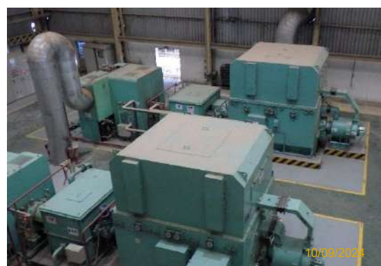
รูปที่ 2-27 การปิดครอบเครื่องจักรอุปกรณ์ที่มีเสียงดัง
