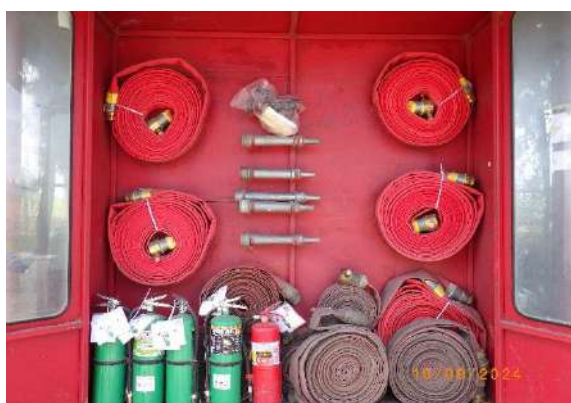
รูปที่ 2-52 ระบบดับเพลิงรอบกองขานอ้อย
